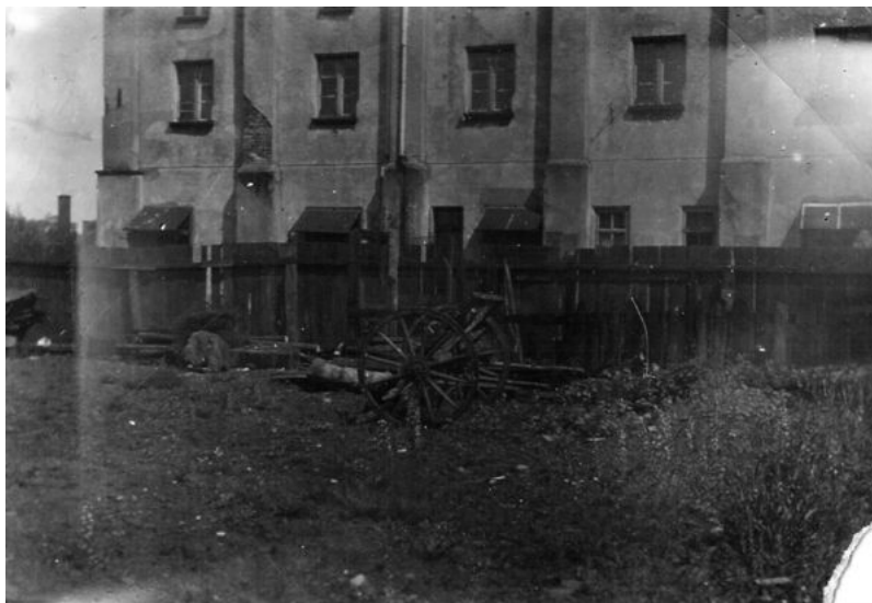
Das Haus an der Bolkenhainer Straße. Es war von eigenwilliger Bauart. Im Erdgeschoß wurden die Wohnungen direkt von außen durch eine Doppeltür betreten,
