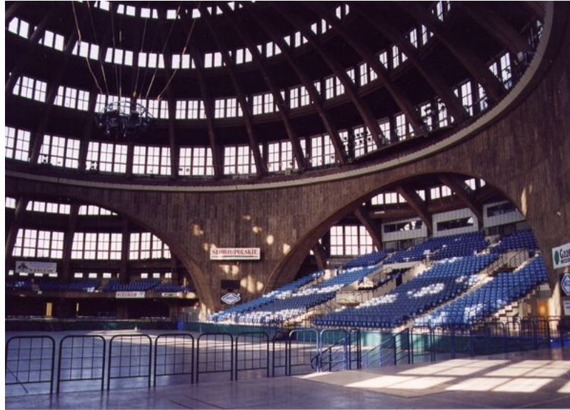
Die Jahrhunderthalle (Baujahre 1911-13) von innen: 100m im Durchmesser, 50m hohe freitragende Betonkuppel. War damals eine Wertsensation. Sie wird auch heute noch genutzt.
